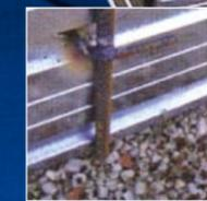
Tirante a 1/3 dell'altezza, agganciato al rompitratta tramite saldatura
