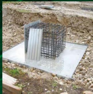
Il pannello viene applicato prima sui 4 lati del dado o zattera di fondazione, poi successivamente, una volta gettata la stessa, si cassetterà sia il bicchiere internamente e/o esternamente, sia gli eventuali collegamenti e, una volta rinterro lo scavo con il materiale inerte, si procederà al getto.
