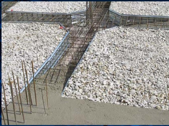
Sarà possibile cassetterare anche in presenza di pavimenti sanitari posizionando il pannello fra gli elementi in plastica e le gabbie di fondazione. Il cassero sarà più alto sul perimetro esterno e più basso su quello interno. In questo modo si potranno gettare, in una sola operazione, le fondazioni, l'interno del vespaio e la cappa sovrastante, ottenendo un'unica soletta monolitica.
