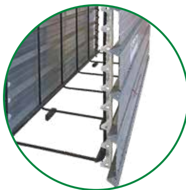
Particolare del distanziatore posizionato tra gabbia e cassero
